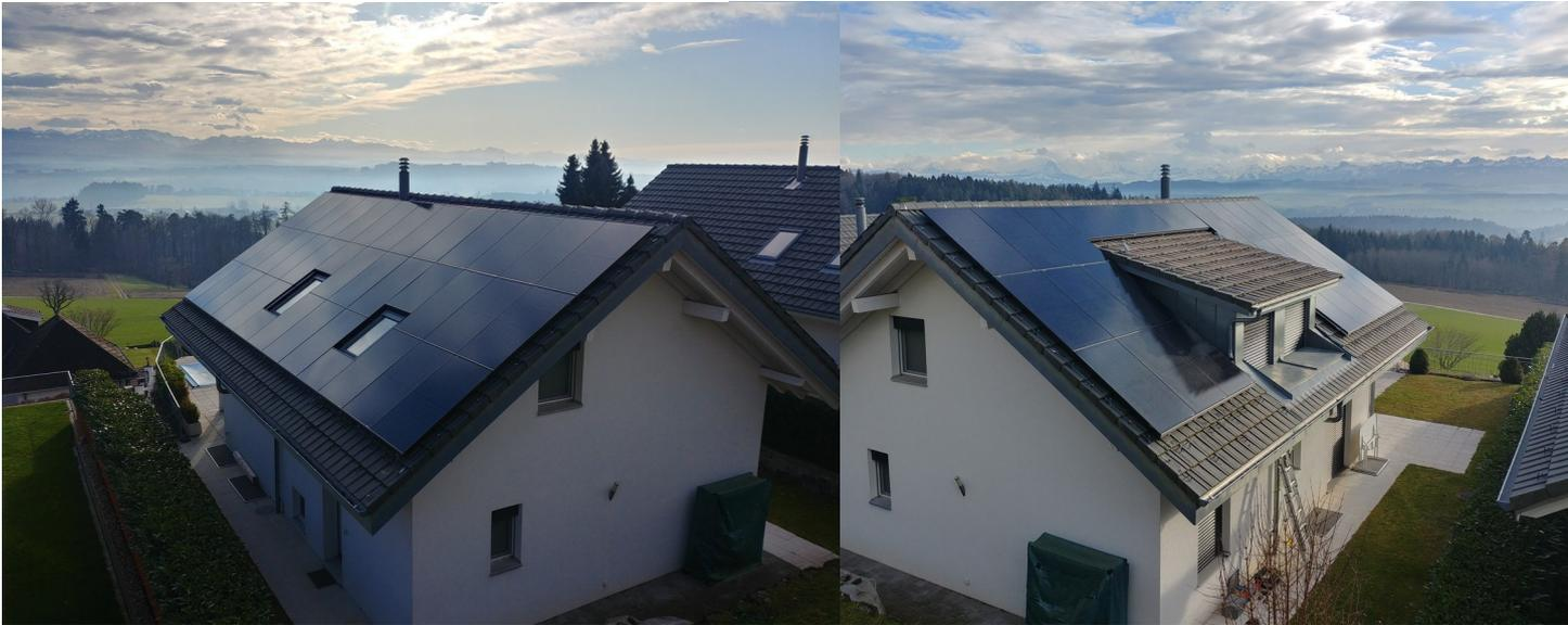
Ost- und Westdach 20kWp inkl. Batteriespeicher und Notstromversorgung, Innerberg
